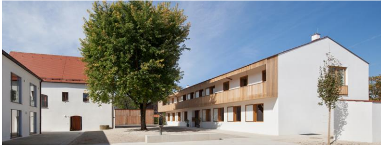
Abbildung 3: Neubau Pfarrhaus Ampfing, Bauherr: Pfarrpfüdestiftung Ampfing, Architekt: Deppisch Architekten GmbH (Freising)
